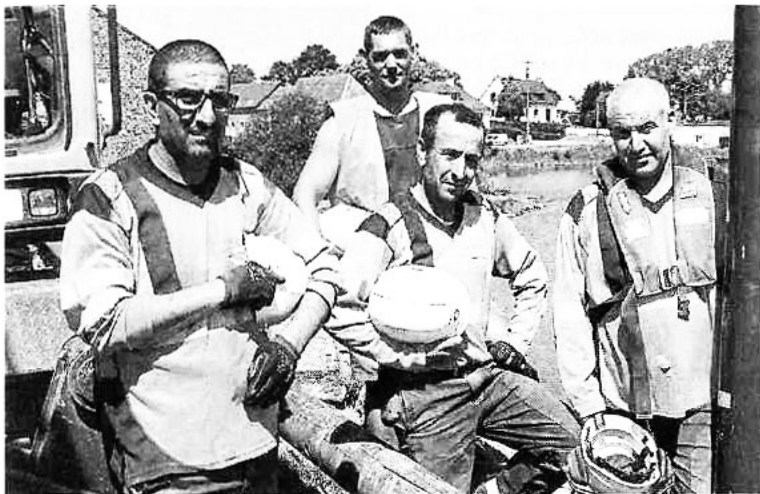
Abdel Kader Belardi, Saleh Badrane, Sébastien Rouxel et Mohamed Marteghanni, de l'entreprise Sethy, s'occupent des travaux.
